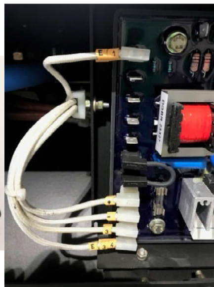
Figura 26. Instalación del AVR GRT7-TH4E en grupo de 200kVA
