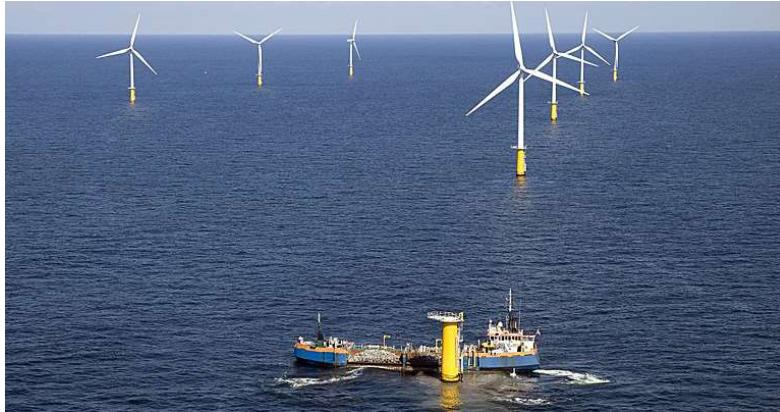
Ilustración 8: Parque eólico de Gemini Wind Farm en Holanda
