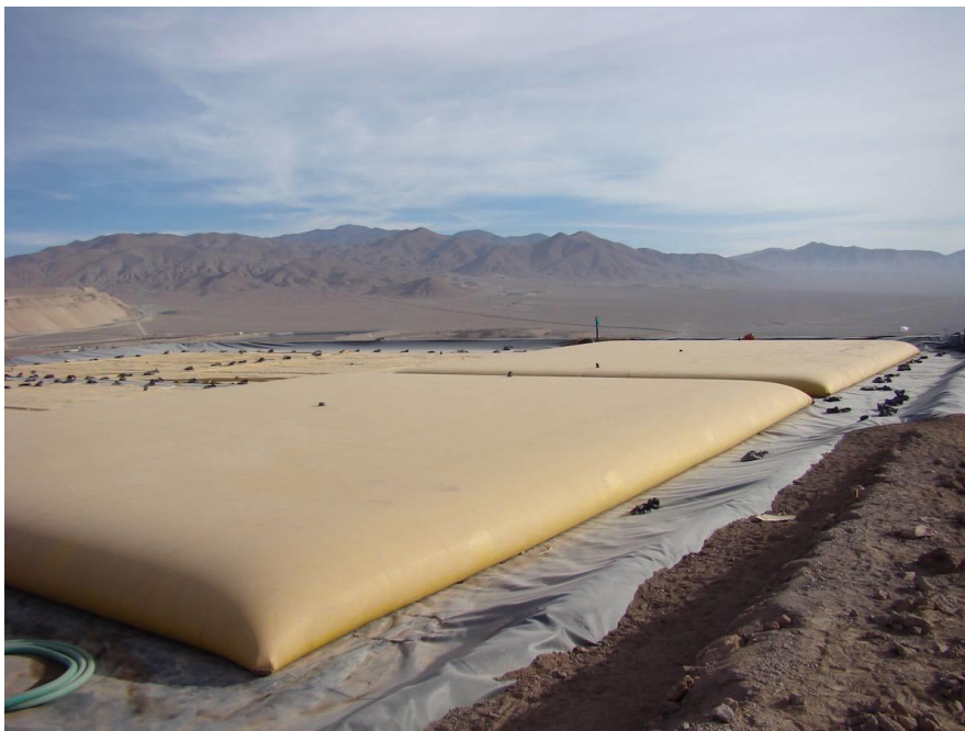
ILUSTRACIÓN 18 EJEMPLO CISTERNA FLEXIBLE. FUENTE: HTTPS://WWW.LABARONNE-CITAF.ES/APLICACIONES-DE-ALMACENAMIENTO/4_RESERVA-DE-AGUA-POTABLE
