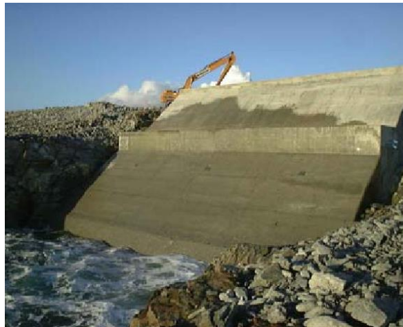
Ilustración 12: Dispositivo OWC onshore [7]
