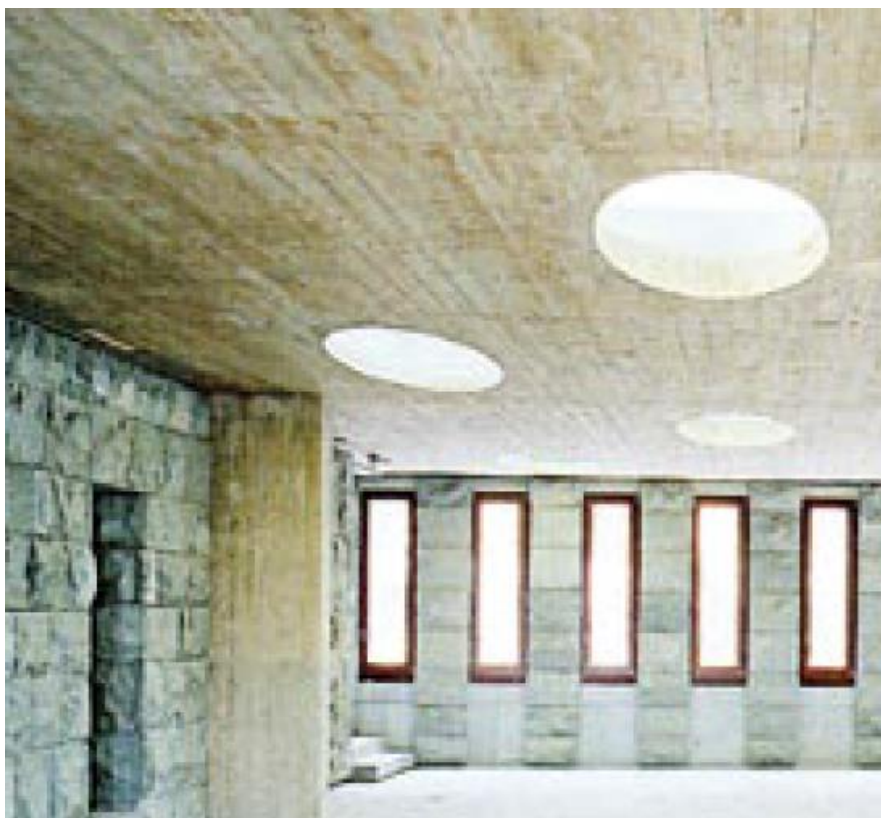
Ilustración 10 Imagen de tres claraboyas, Fuente: Guía técnica: aprovechamiento de la luz natural en la iluminación de edificios del IDAE
