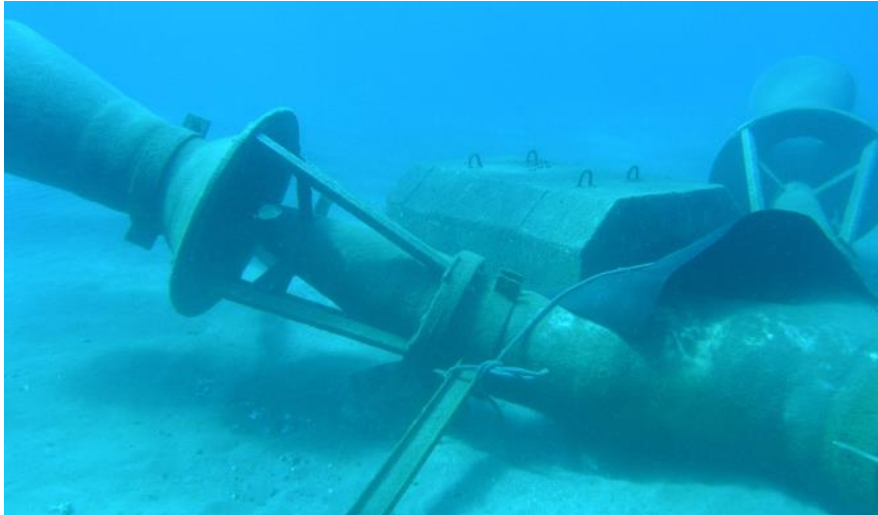
Figura 32. Difusor Venturi de Maspalomas II. (Fuente: Instituto tecnológico de Canarias)
