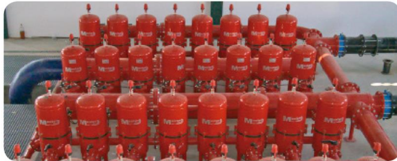
Figura 61. Configuración filtros de anillas en paralelo. (Fuente: catálogo filtro Lama MasterMegadisc)
