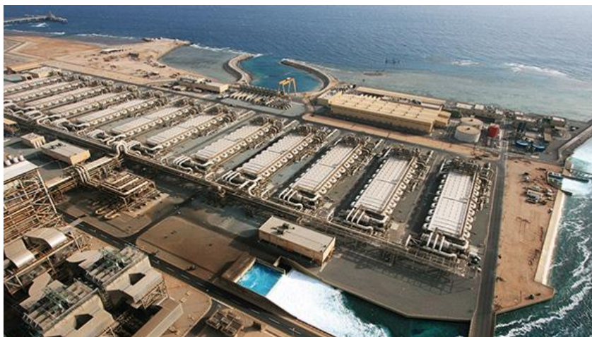
Figura 6. Desaladora de Ras Al-Khair, Arabia Saudí. (Fuente: Doosan)
