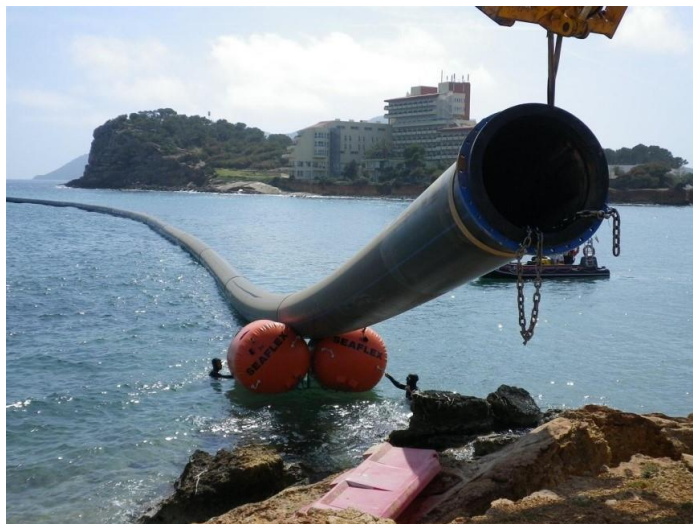
Figura 12. Inmisario durante la fase de instalación (Fuente: Mario de Miguel Bello)
