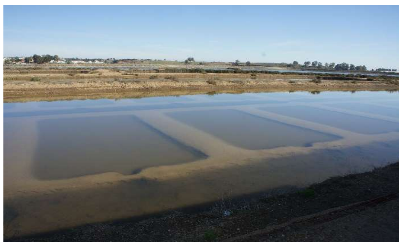
Ilustración 21. Cristalizadores y corredor secundario inundados.
