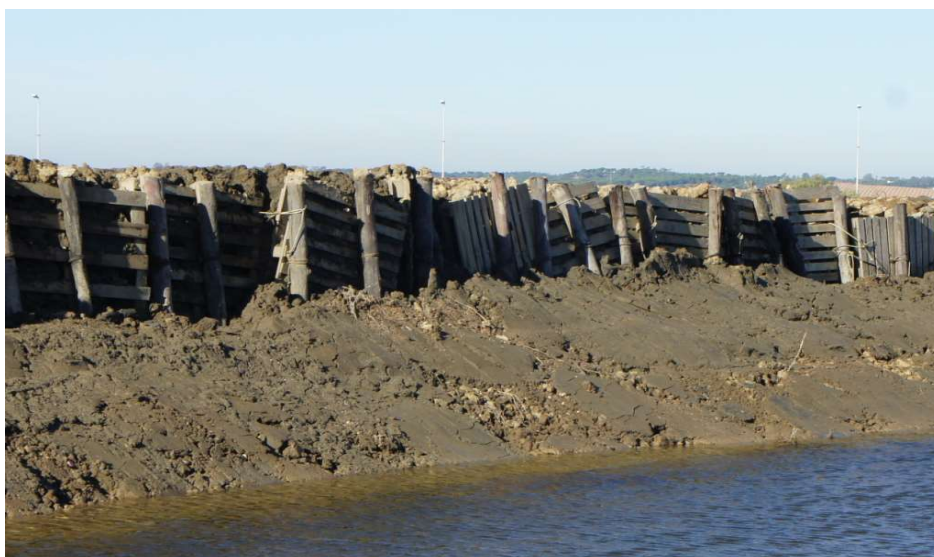
Ilustración 18. Muro que separa del estero.
