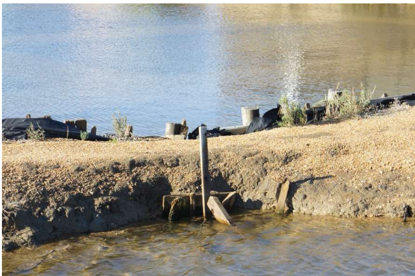
Ilustración 17. Compuerta que separa balsa de concentración y cristalizadores.
