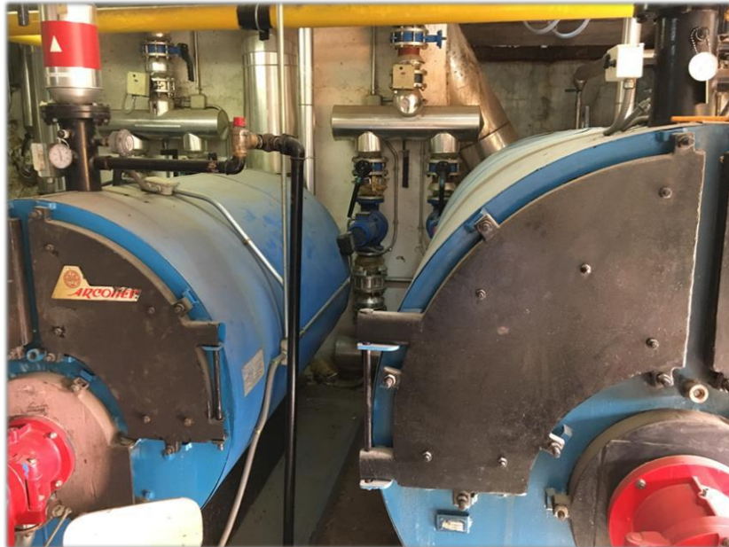
Fotografía 6. Bombas del circuito de calderas. Fuente: propia.
