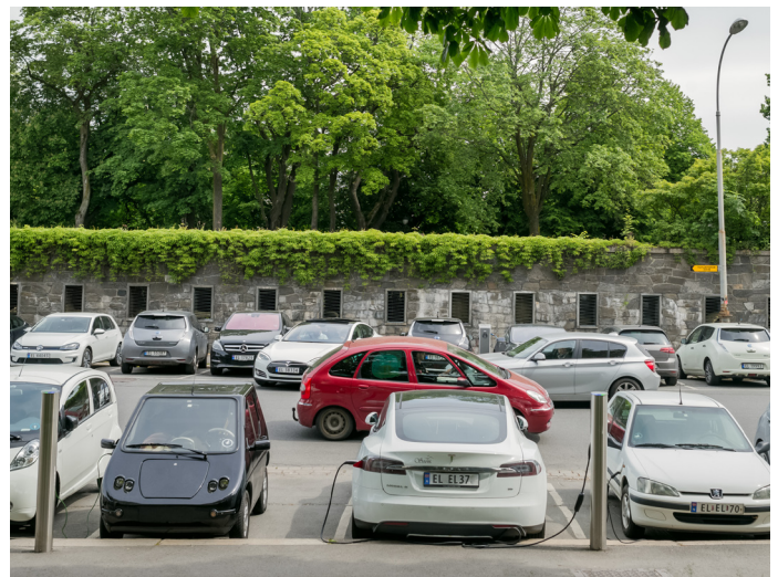
Infraestructura de estaciones de carga para vehículos eléctricos en Oslo
