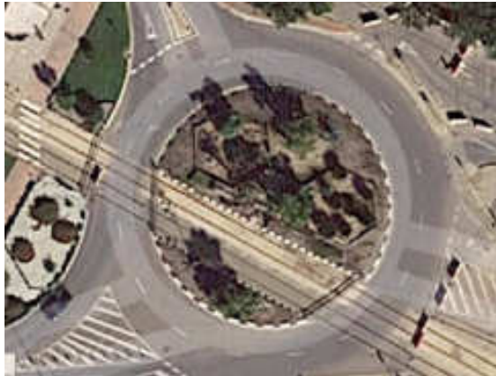
Imagen 56: intersección especial nº 18. Fuente: Puerto de Castellón
