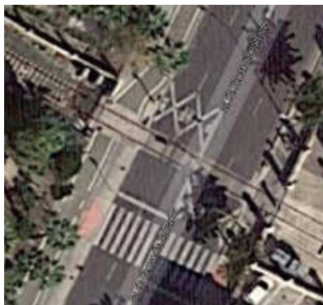
Imagen 55: intersección especial nº 21. Fuente: Puerto de Castellón
