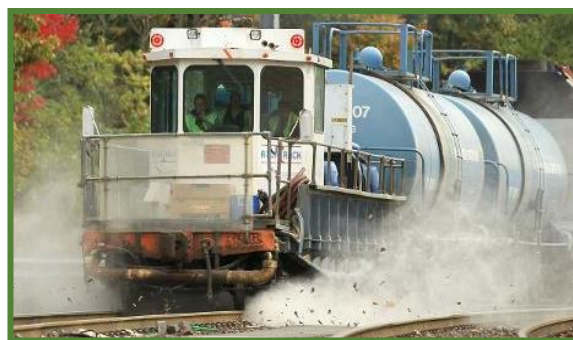
Ejemplo de tren de limpieza de carril con agua a presión.
