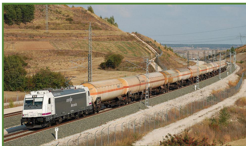
Mercancías en la variante de Burgos. Se aprecia la rampa de 15mm así como el espacio para una tercera vía.
