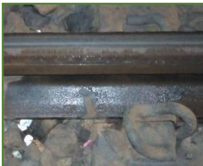
Patrón ranurado impreso sobre el carril
