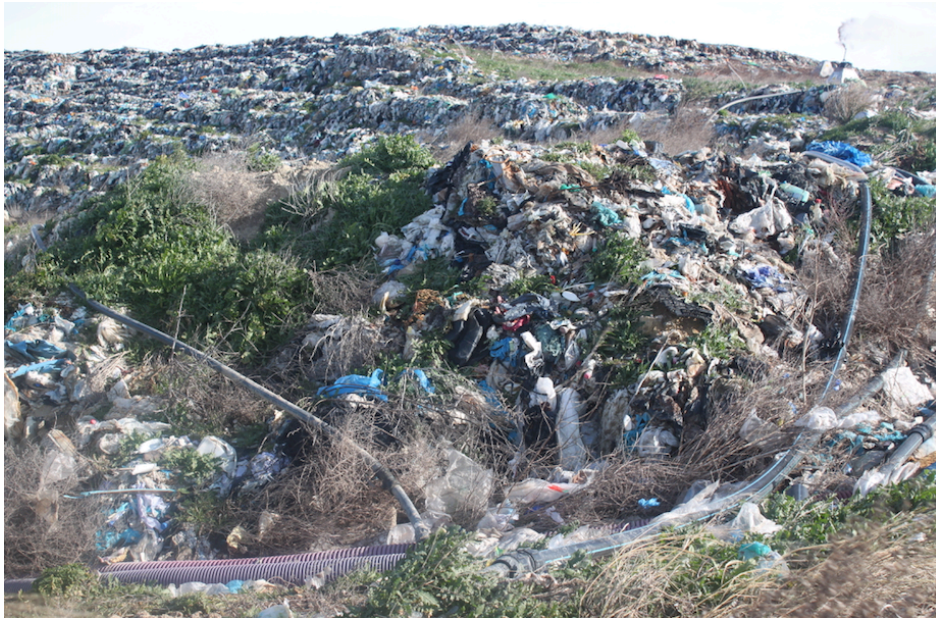
Figura 9. Tuberías de canalización de lixiviados [7]
