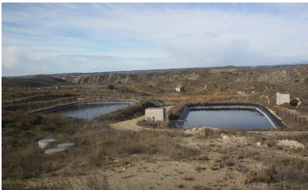
Figura 10. Balsas de lixiviados GAZO [7]
