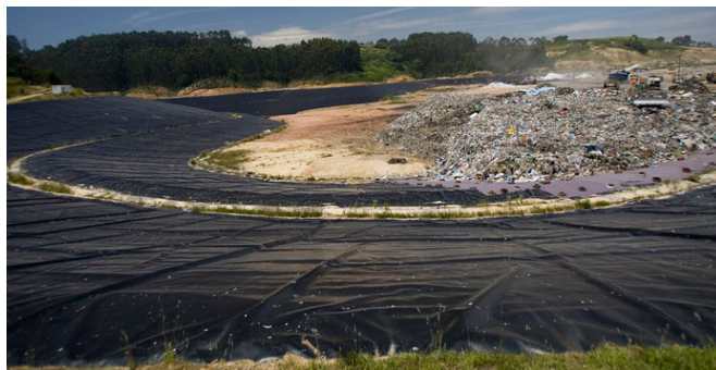
Figura 1. Vertedero controlado residuos no peligrosos COGERSA (Asturias) [2]
