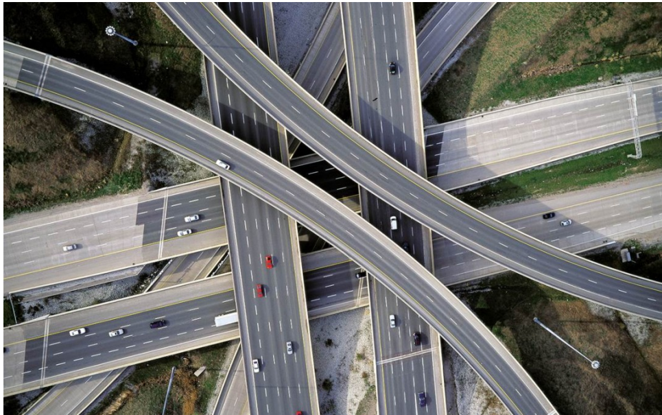
Figura 4. Imagen infraestructura de carreteras [7]
