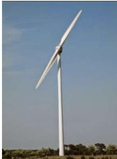
Imagen 11: Aerogenerador bipala. Fuente: energía eólica para todos los públicos.
