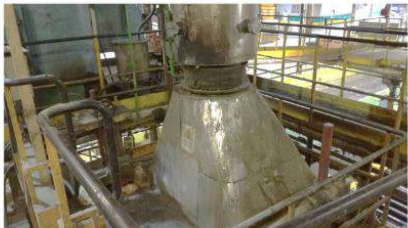
Figura 49: Campana de los conductos extractores de las secciones de entrada (izquierda) y salida (derecha).
