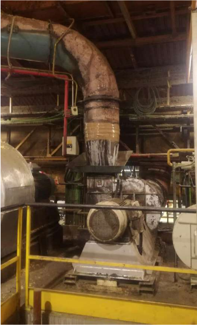
Conducto del lavado de humos de la sección de entrada.
