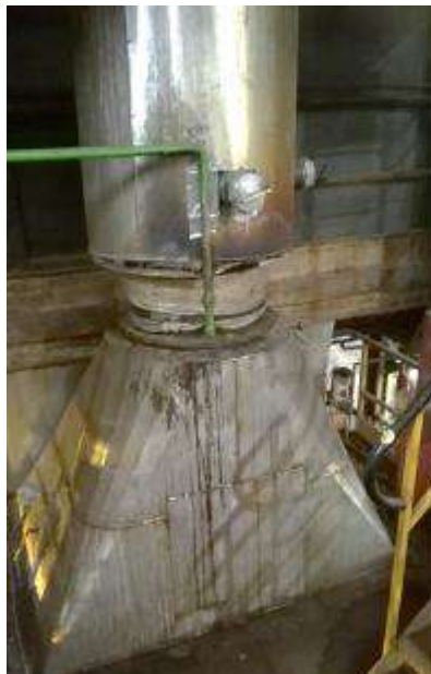
Figura 49: Campana de los conductos extractores de las secciones de entrada (izquierda) y salida (derecha).
