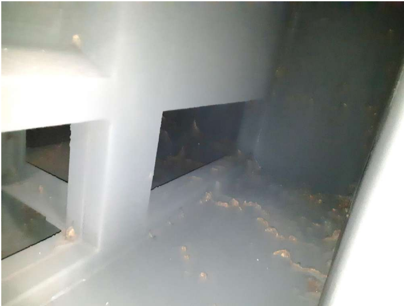
Interior de otro cajón sin apenas lana acumulada.
