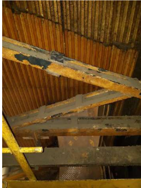
Figura 84: Ausencia de una parte de la barandilla que hay en la zona del Venturi de la entrada.
