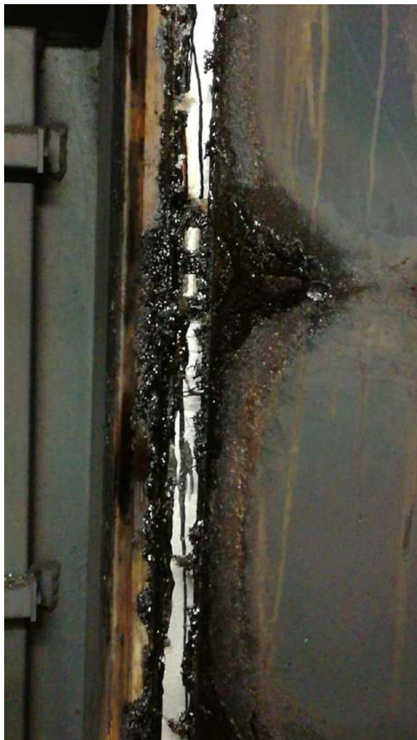
Acumulaciones de encolado y sellado de las puertas deteriorado
