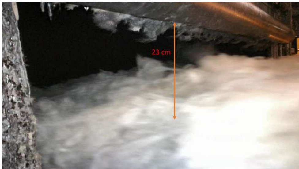
Figura 86: Apertura excesiva de la puerta frontal de la sección de entrada.
