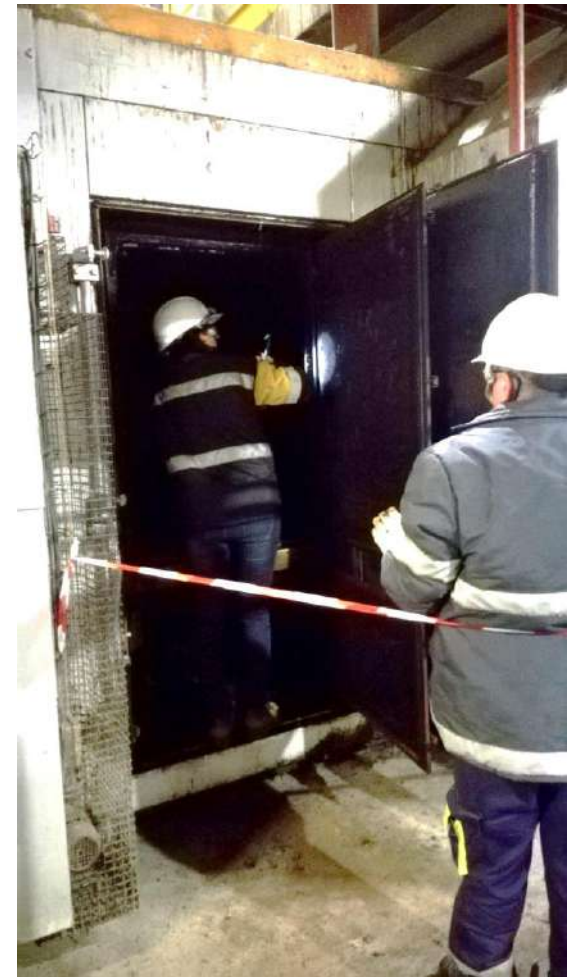
Inspección del interior del cajón.
