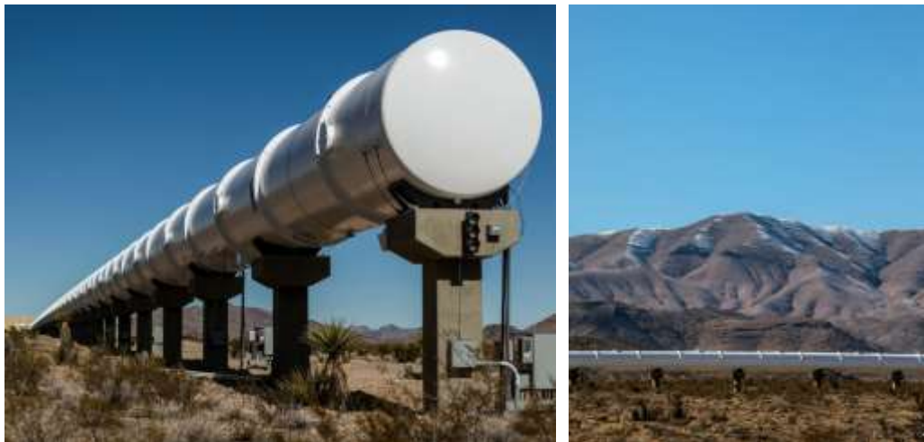
Figura 47. Imágenes del DevLoop desierto de Nevada. Fuente: New York Times.
