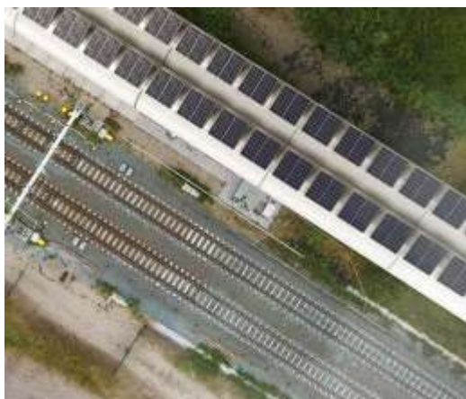
Figura 36. Instalación de placas solares sobre los tubos. Fuente: HARDT.
