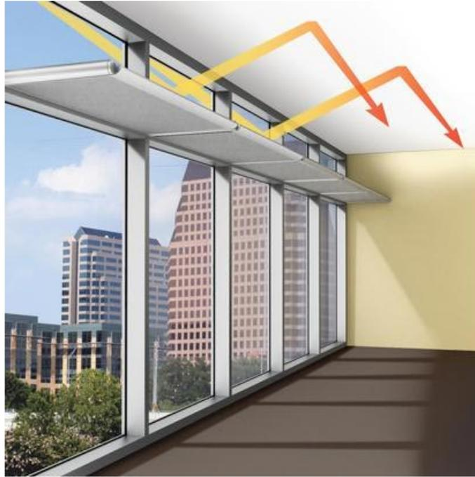
Figura 3.- Uso de energía solar pasiva para aprovechamiento de luz solar como iluminación natural (Fuente: Soluciones Especiales).
