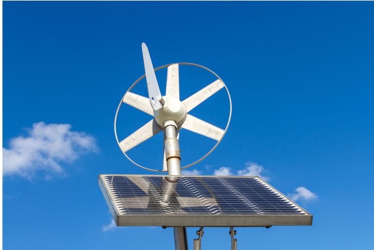
Figura 5.- Energía híbrida - fotovoltaica y eólica (Fuente: Hogarsense).
