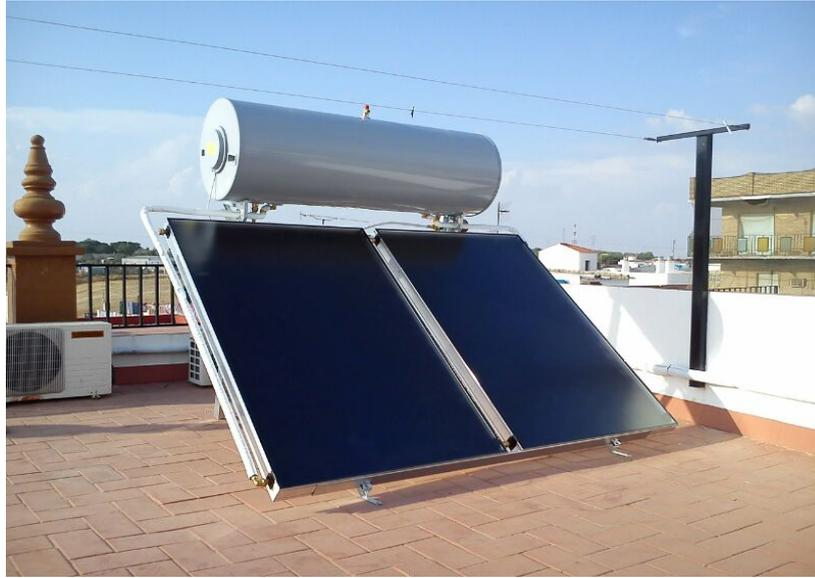
Figura 7.- Panel solar térmico (Fuente: Insene Energía).
