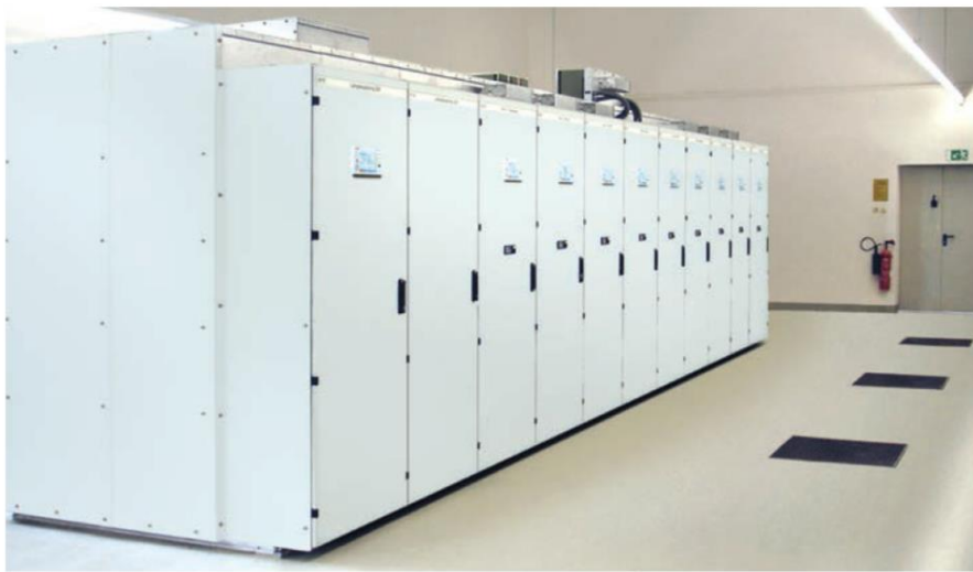
Fig. 32: Celdas modelo ZX2 del fabricante ABB
