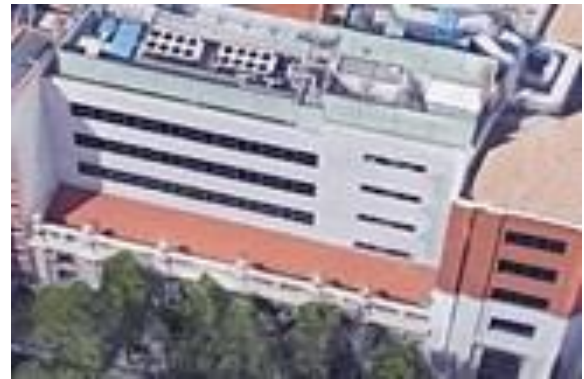
Ilustración 11: Vista aérea en 3D de la ampliación 1. Fuente: Google Earth
