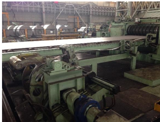
Figura 20: Proceso de rebordeado en una línea de corte
