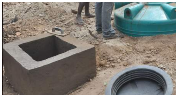
Ilustración 35. Silo terminado. Fuente: Manuel Moreno.
