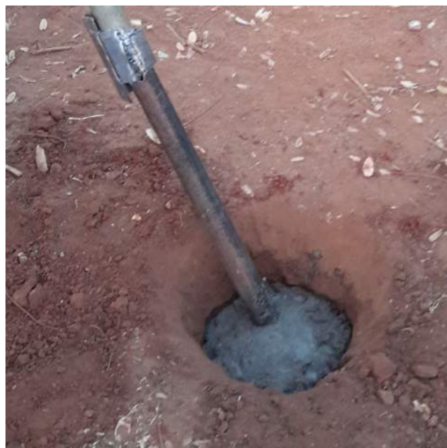
Ilustración 63. Cimentación del columpio de 45 cm de profundidad.
