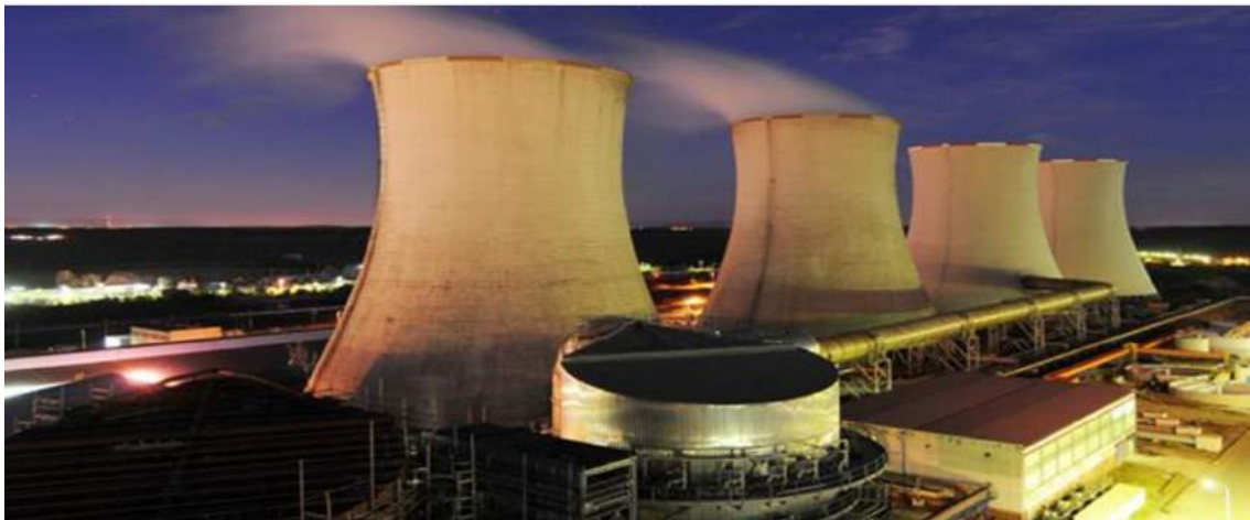
Ilustración 15. Estación térmica de Hwange. Fuente: Construction Review Online.
