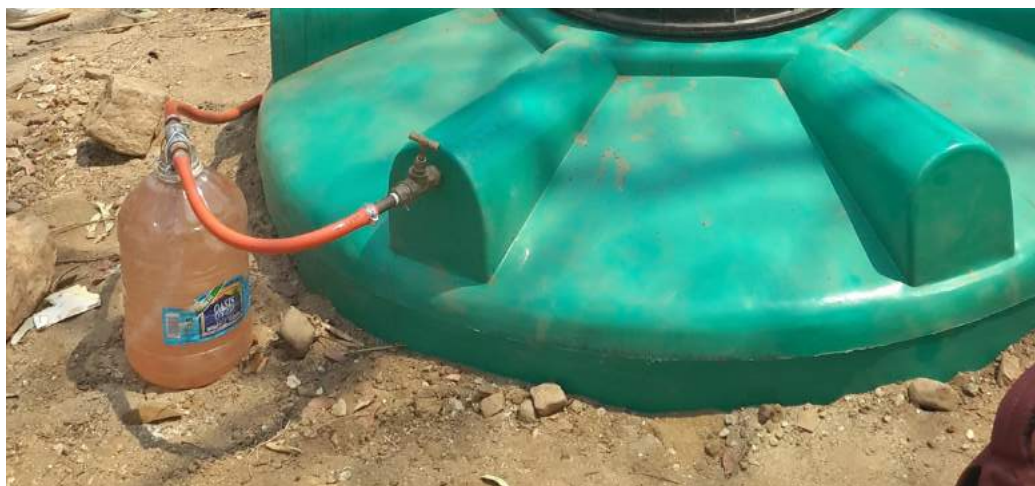
Ilustración 36. Válvula de seguridad. Fuente: El autor.
