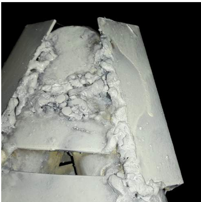
Ilustración 64 Soldadura en la unión de los tres postes. "Algo barroca , pero resistente"
