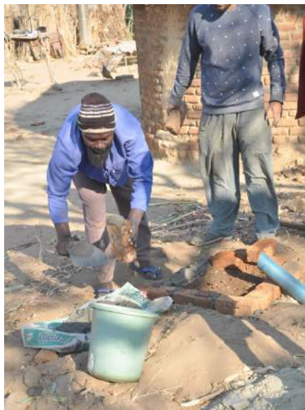
Ilustración 34. Construcción del silo de salida. Fuente: Manuel Moreno
