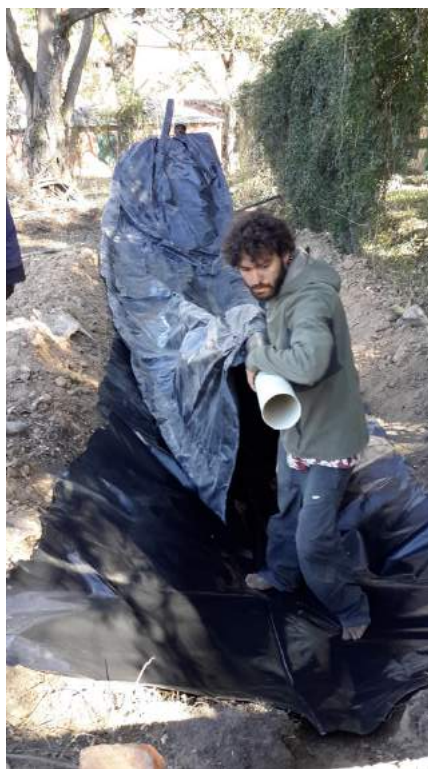
Ilustración 53. Momento de la instalación del digestor.
