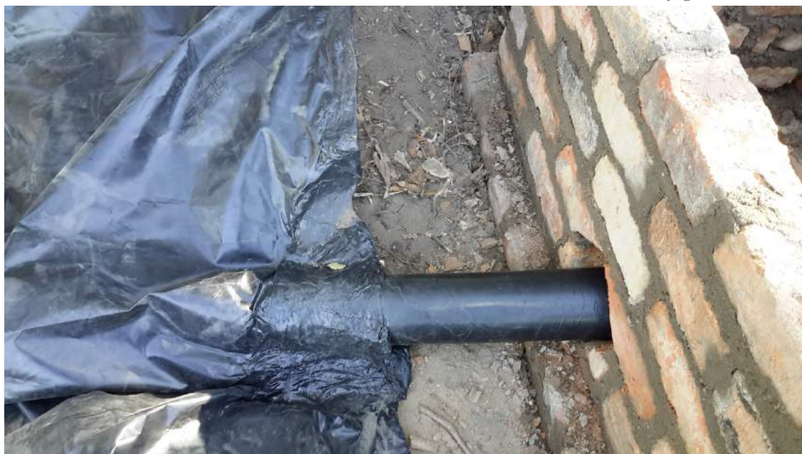
Ilustración 30. Unión de la tubería de entrada.
