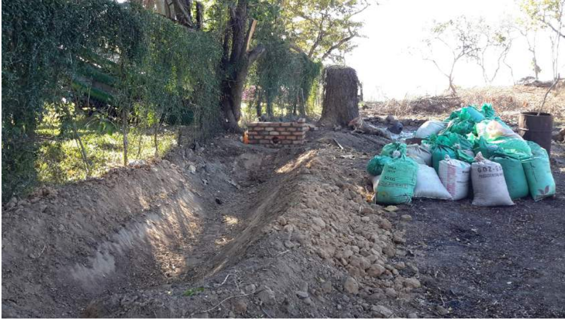
Ilustración 44. El resultado final con la zona de trabajo despejada. Los sacos de la derecha contienen heces de vaca y cerdo y rastrojo de trigo. Fuente: el autor.
