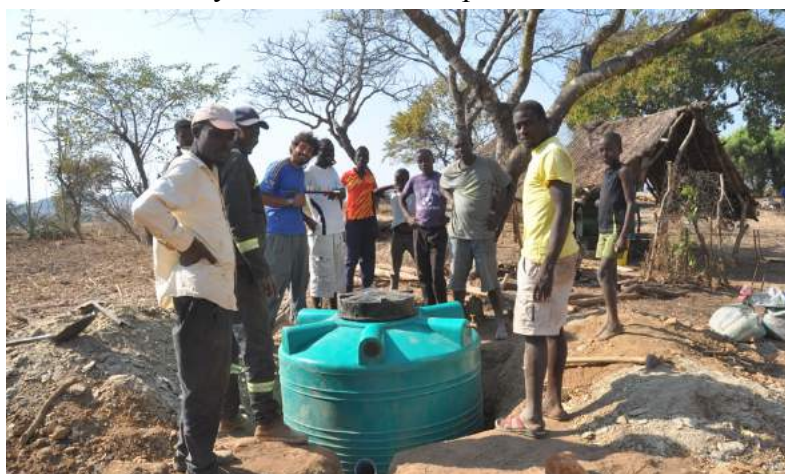
Ilustración 32. Tanque instalado con tuberías. Se puede apreciar el agujero superior sellado con plástico fundido. Fuente: Manuel Moreno.
