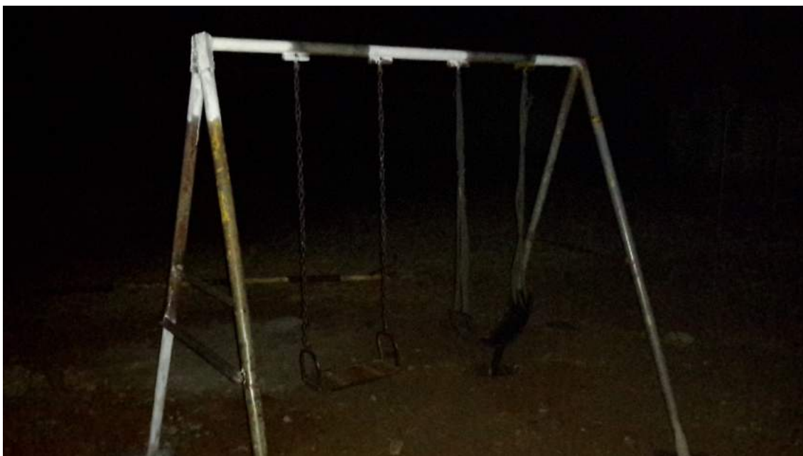
Ilustración 65. Resultado de la estructura antes de pintar.
