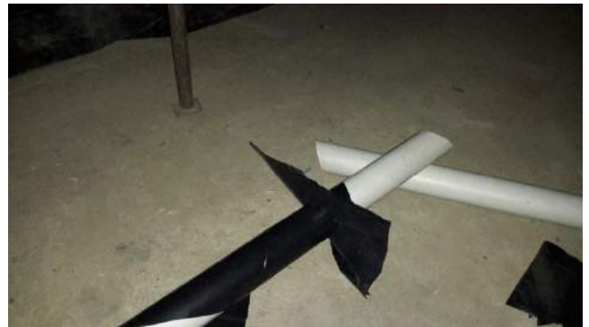
Ilustración 45. Preparación de las tuberías. Fuente: El autor.
