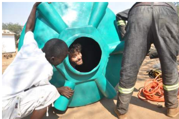
Ilustración 31. En el interior del tanque para sellar el agujero y apretar la tuerca del conducto de salida. Fuente: Manuel Moreno
