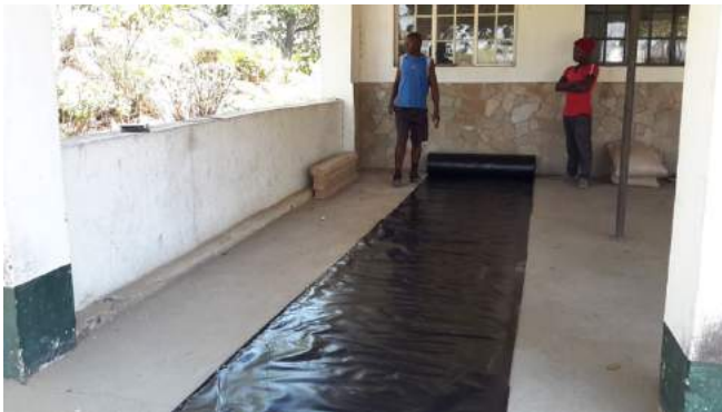
Ilustración 46. Preparación de la lona de PVC. Fuente: El autor.
