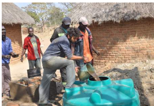
Ilustración 40. Primer llenado del digestor. Fuente: Manuel Moreno.
