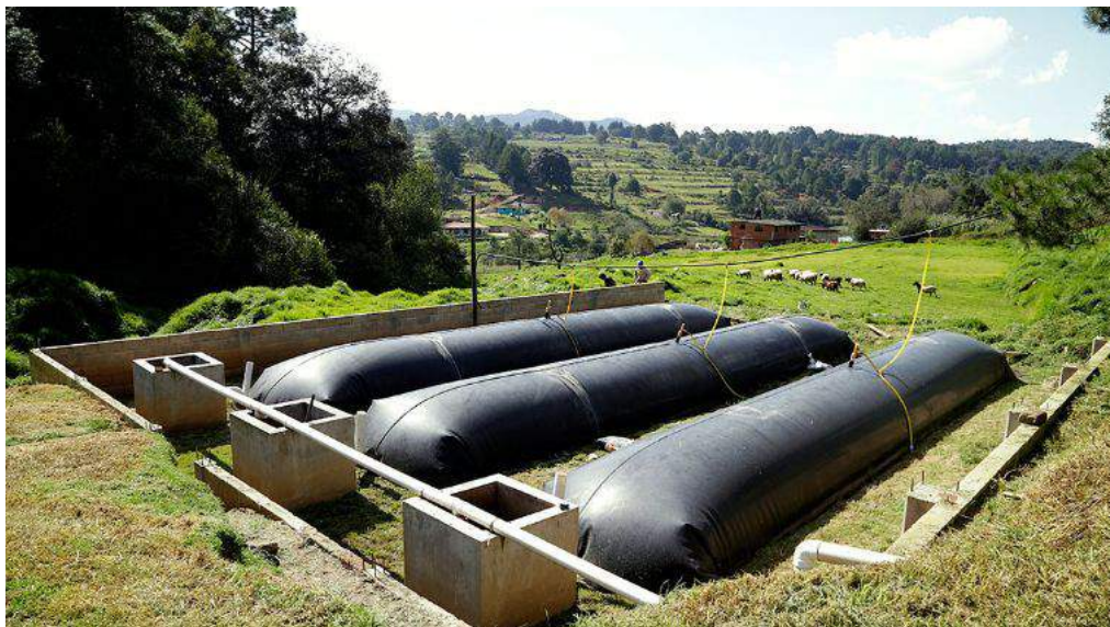
Ilustración 27. Tres biodigestores horizontales instalados en paralelo. Fuente: Sistema biobolsa.
