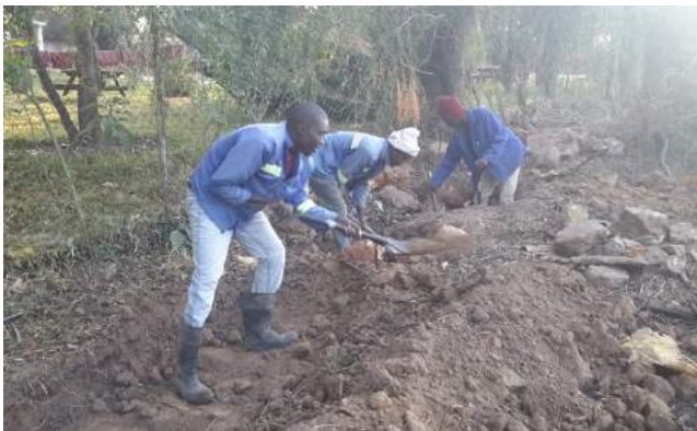
Ilustración 43. Trabajadores cavando. Fuente: el autor.
