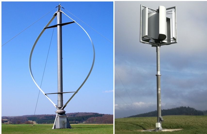
Figura 6: Turbinas de eje vertical: Darrieus a la izquierda y Savonius a la derecha. Fuente: elaboración propia.
