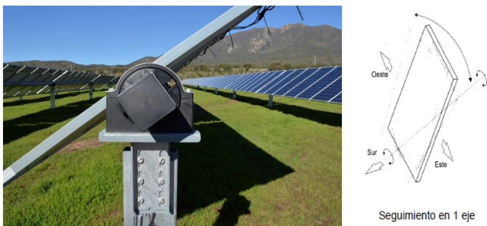
Figura 12. Seguidor solar de un eje (este-oeste). (Fuente: [24])
