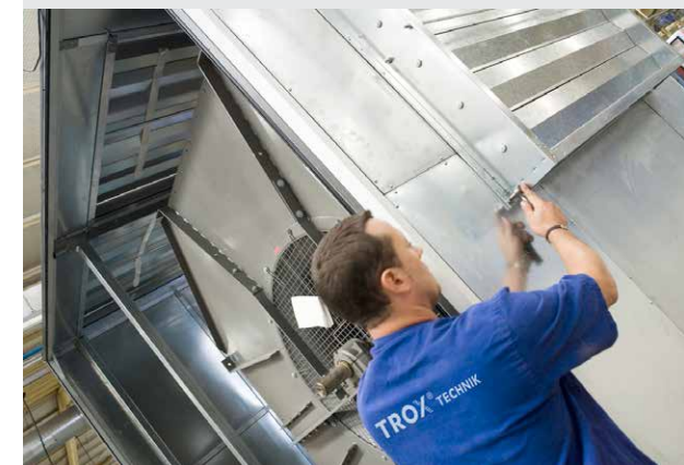
Ensamblaje en fábrica de componentes
