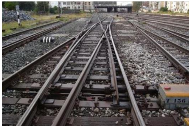
Figura 46 Travesía de unión sencilla [JTCU15]
