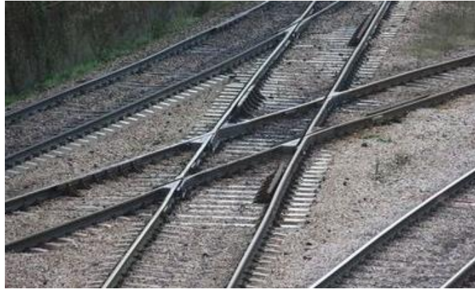
Figura 44 Travesía sin unión [JTCU15]
