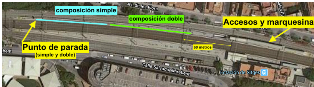
Figura 35. Estación de Sitges. Marquesina situada a 60 (o 150) metros de la cola del tren
