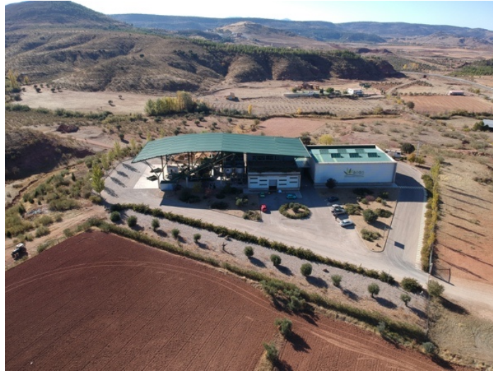
Figura 10: Vista aérea almazara OliNexo
