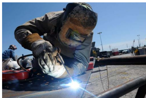
Imagen 93: Soldador Realizando una Soldadura SMAW
