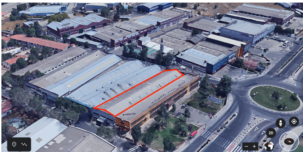
Figura 6: Imagen aérea de la nave industrial (en color rojo)
