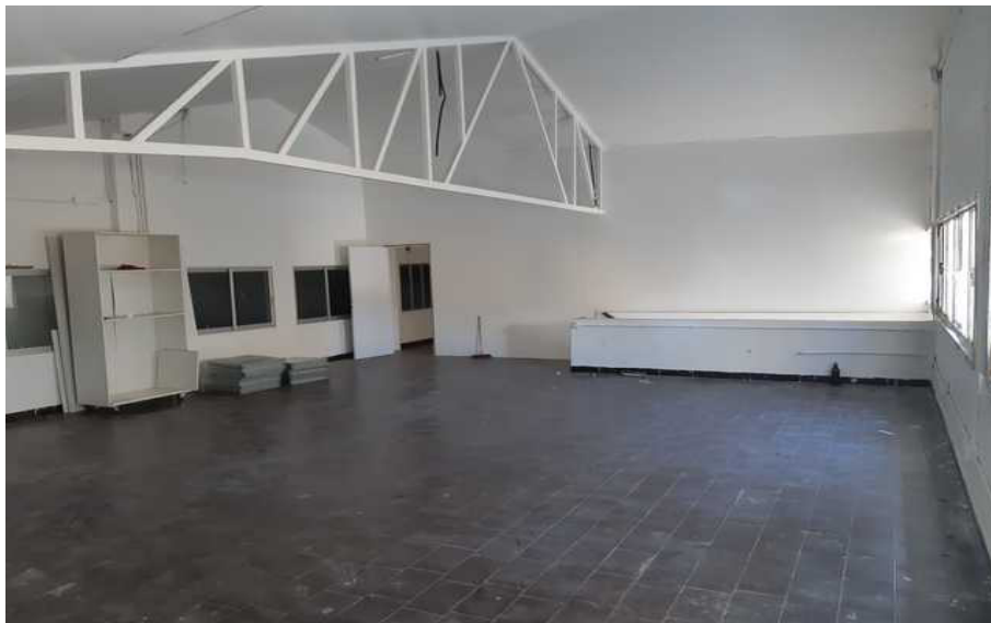
Figura 11: Fotografía de la planta primera. Oficina.
