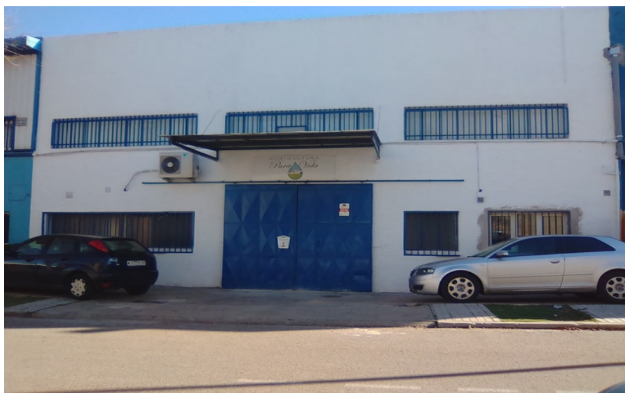
Figura 20: Fachada de la nave industrial
