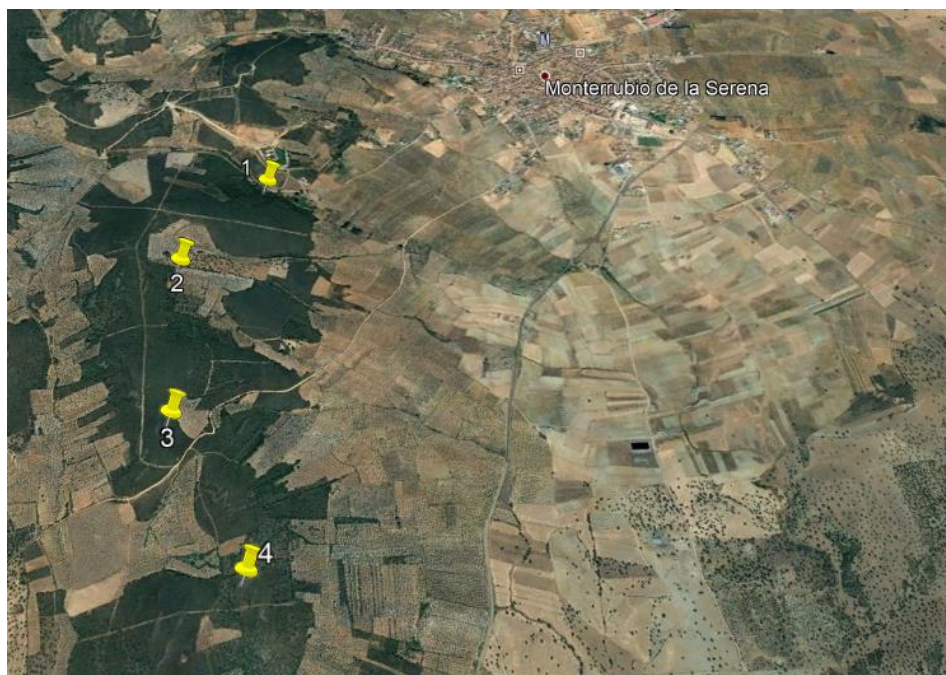
Ilustración 16: Localización de los aerogeneradores.
