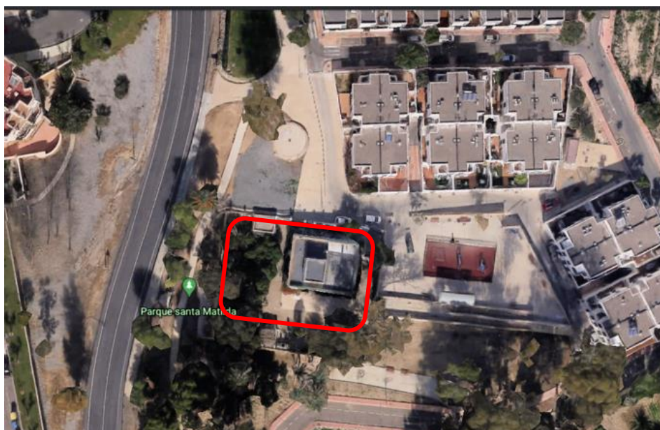
Ilustración 5. Vista aérea de los lindes de la vivienda. (Fuente: Google Earth)
