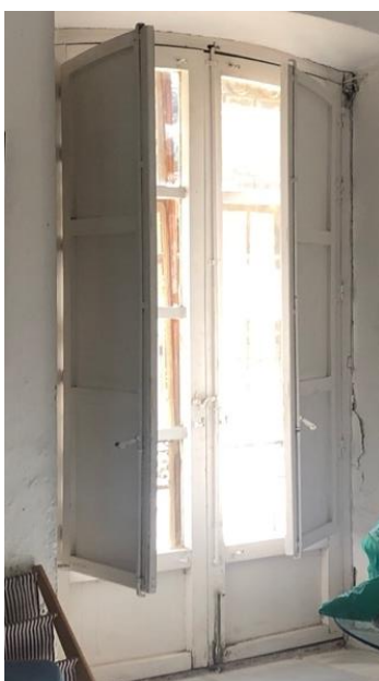
Ilustración 8. Ventanal de la vivienda. (Fuente: Elaboración propia)
