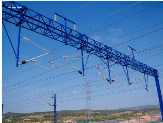
Ilustración 10 Pórtico (fotografía: https://www.eadic.com/elementos-de-sustentacion-para-la-catenaria-c-350/ )
