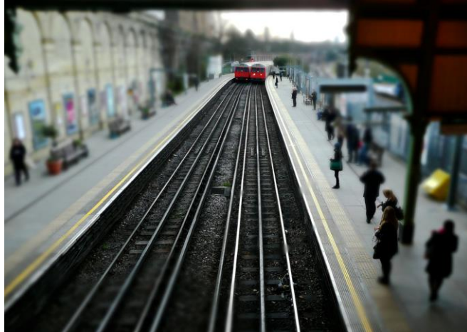
Ilustración 4 Cuarto Carril - Metro Londres (fotografía: https://www.trenvista.net/descubre/mundo-ferroviario/la-electricacion-de-los-ferrocarriles/ )
