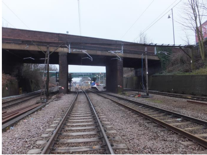
Ilustración 24 Paso inferior visto desde apoyo 13-15
