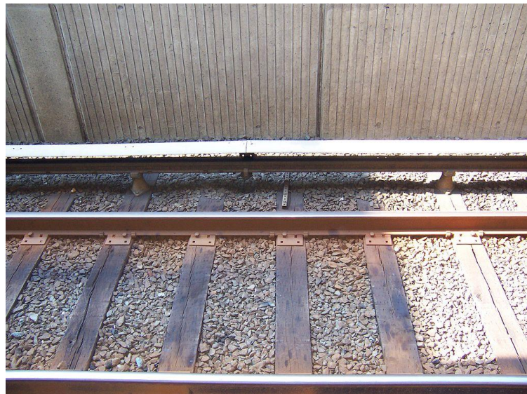
Ilustración 3 Tercer Carril - Metro West Falls Church (fotografía: https://es.wikipedia.org/wiki/Tercer_riel_(alimentaci%C3%B3n)#/media/Archivo:WMATA_third_rail_at_West_Falls_Church.jpg )
