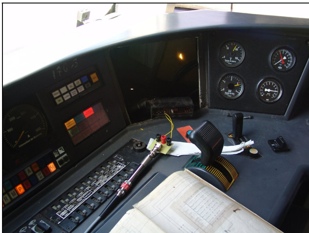
Figura B-13. Punto de conexión en el bus del tren.
