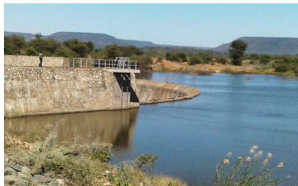
Ilustración 16: Vista de la pared de la presa en Mutange. Fuente: [10]
