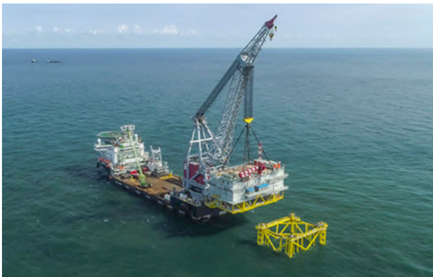
Figura 74. Proceso de instalación de la subestación marina [65].
