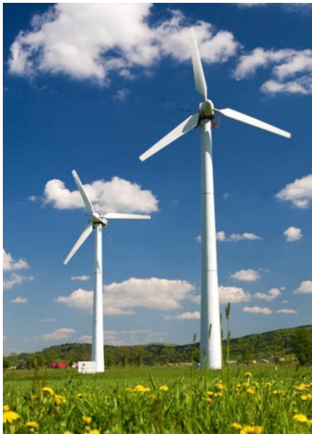
Figura 3: Turbina de eje horizontal de tres palas.
