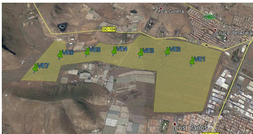
Figura 17: Aspecto general turbinas del P.E. Bufadero. (Google Earth)
