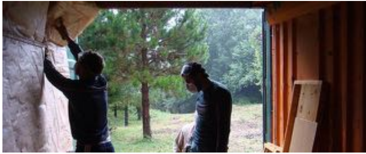
ILUSTRACIÓN 42. PROCESO DE AISLAMIENTO 48
