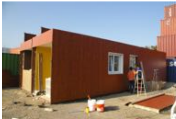
ILUSTRACIÓN 38. INSTALACIÓN DE FACHADA 44
