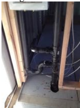
ILUSTRACIÓN 81. INSTALACIÓN DE AGUAS NEGRAS 100
