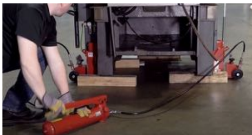
ILUSTRACIÓN 60. ELEVACIÓN DE CONTENEDOR CON COMPRESOR 75
