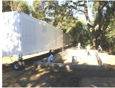
ILUSTRACIÓN 53. CIMENTACIÓN MEDIANTE MURO CORRIDO 47
