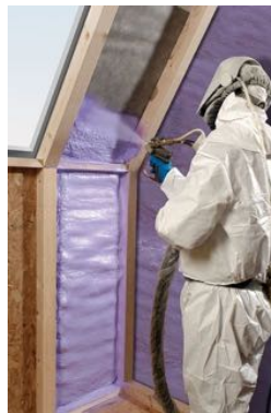
ILUSTRACIÓN 47. AISLAMIENTO EN ESPRAY 49
