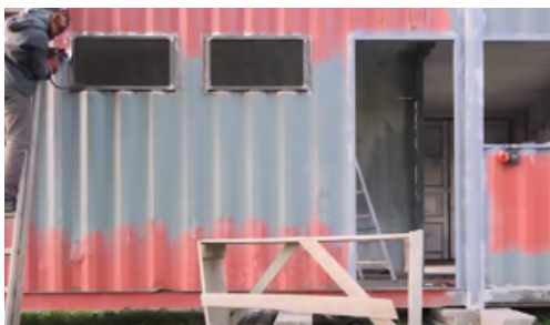
ILUSTRACIÓN 65. APERTURA DE HUECOS 87
