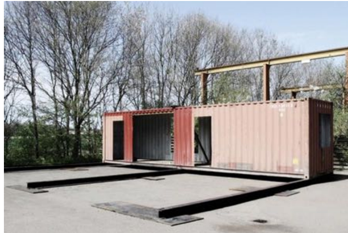
ILUSTRACIÓN 40. APERTURA DE HUECOS 47
