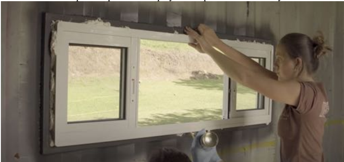
ILUSTRACIÓN 70. COLOCACIÓN DE ESPUMA EXPANSIVA AISLANTE 87
