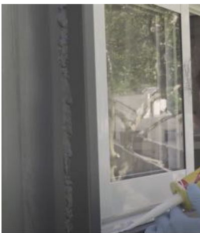
ILUSTRACIÓN 73. COLOCACIÓN DE POLIURETANO SELLANTE 87
