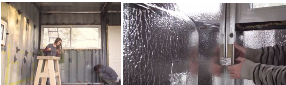
ILUSTRACIÓN 75. DETALLE PRIMERA CAPA DE AISLANTE 94
