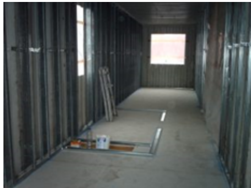
ILUSTRACIÓN 33. INSTALACIÓN DE PERFILERÍA DE SUJECCIÓN DE PLADUR 44
