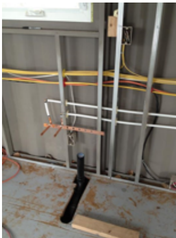
ILUSTRACIÓN 79. INSTALACIÓN DE FONTANERÍA 100
