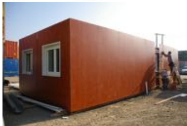
ILUSTRACIÓN 39. INSTALACIÓN DE FACHADA 44
