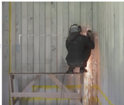
ILUSTRACIÓN 66. USO DE CORTADORA RADIAL 8788
