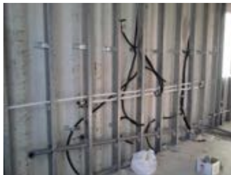
ILUSTRACIÓN 34. INSTALACIÓN DE SUMINISTROS 44
