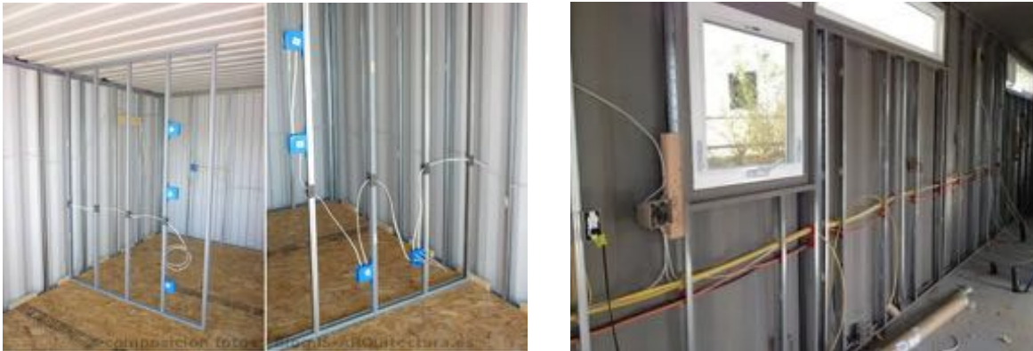
ILUSTRACIÓN 80. INSTALACIÓN ELÉCTRICA 100
