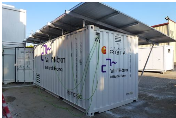
ILUSTRACIÓN 123. VISTA TRASERA PLANTA SOLAR 151
