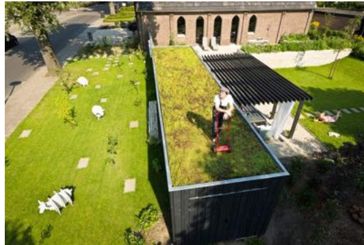
ILUSTRACIÓN 50. CUBIERTA VERDE AISLANTE 47
