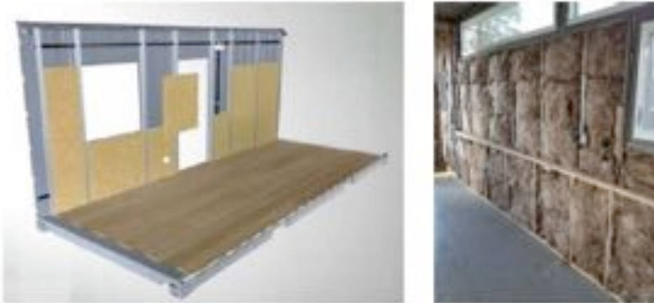
ILUSTRACIÓN 35. COLOCACIÓN DEL AISLAMIENTO 46
