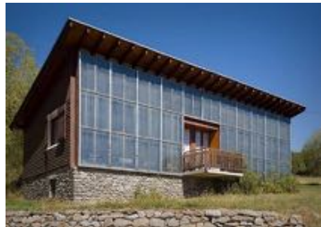
ILUSTRACIÓN 51. MURO TROMBE AISLANTE 52
