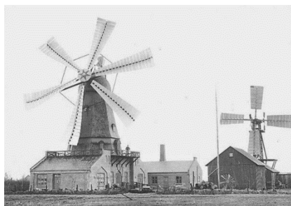
Figura 4: Primer aerogenerador eléctrico
