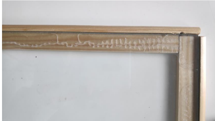
Figura 40. Aumento de la cola blanca entre cristal y marco
