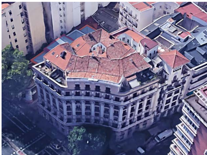
Figura 24: Vista aérea de la cubierta del edificio. Google Earth
