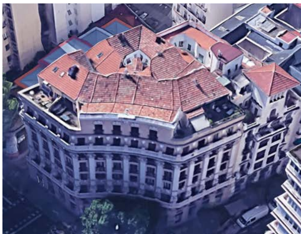
Ilustración 1: Vista aérea del edificio
