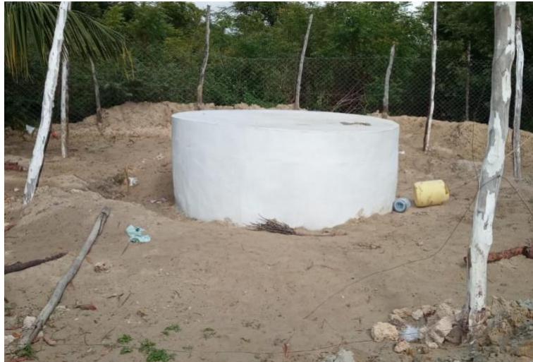
Figura 17. Pozo de extracción de agua. (Fuente: Anidan )
