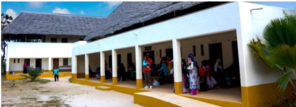
Figura 4. Hospital pediátrico. (Fuente: anidan.org)
