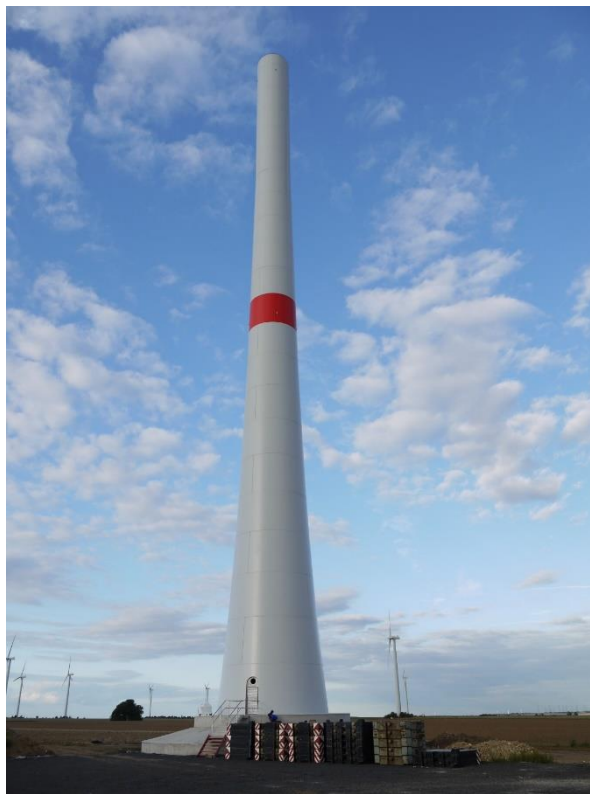
Figura 25: Torre de un aerogenerador
