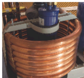
Condensador refrigerado por agua.
