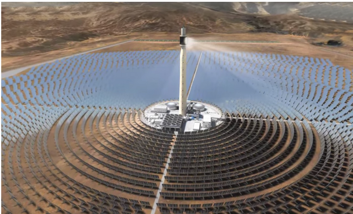
Figura 1-2 - Estación termosolar de torre en Marruecos
