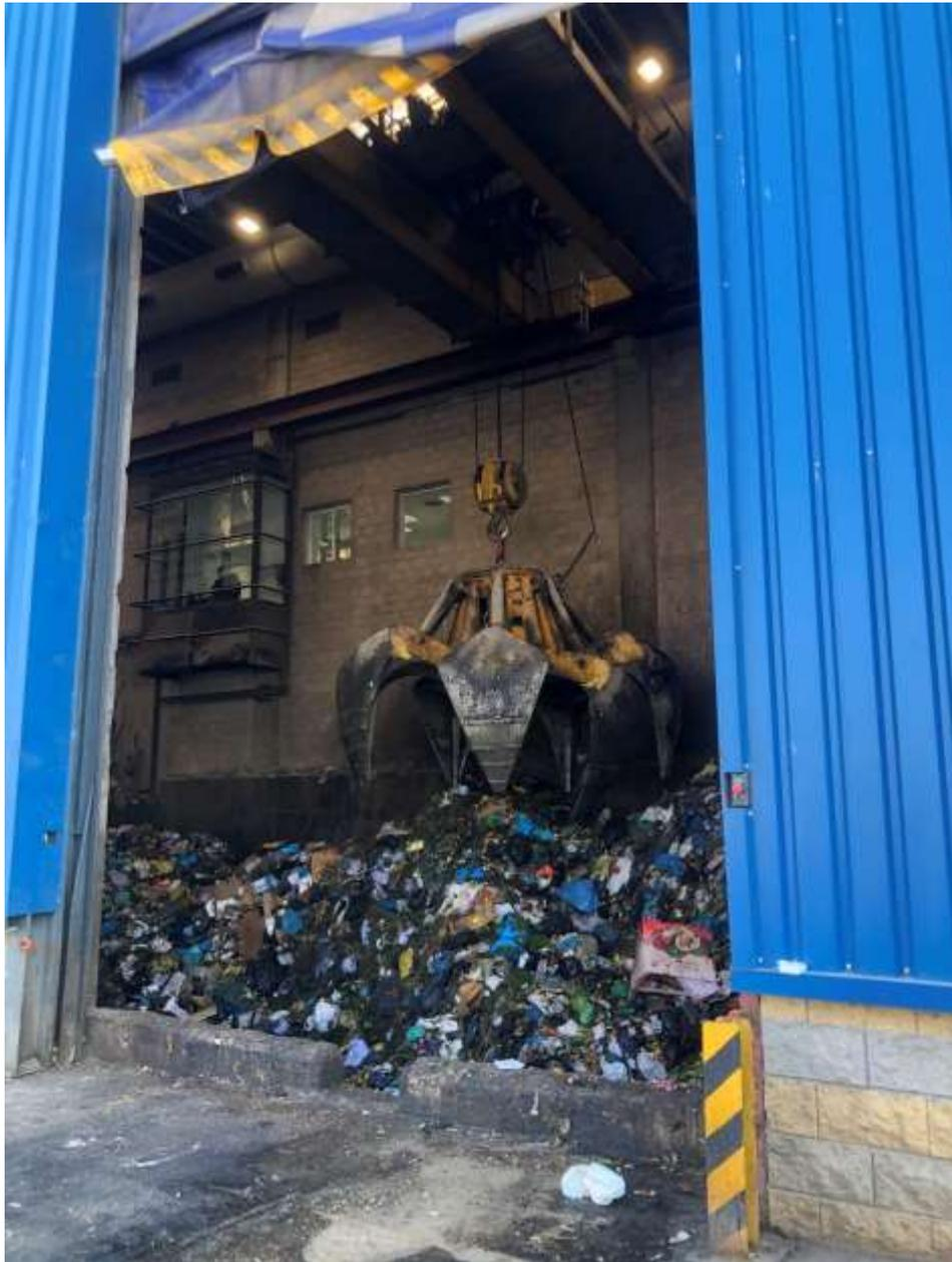
*Figura 48. Fosos de recepción de la Planta de Biometanización de Las Dehesas [58]*
