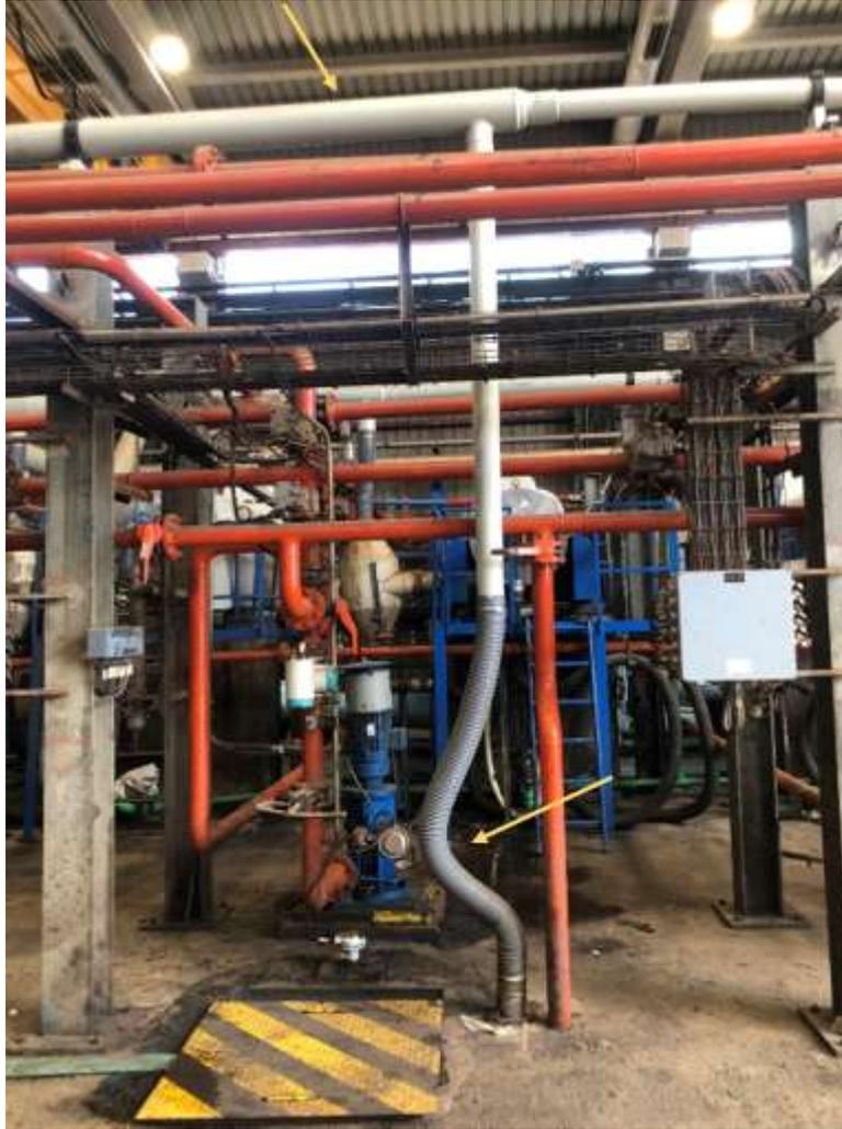
Figura 59. Conductos de captación localizada en la nave de deshidratación [6] [68]
