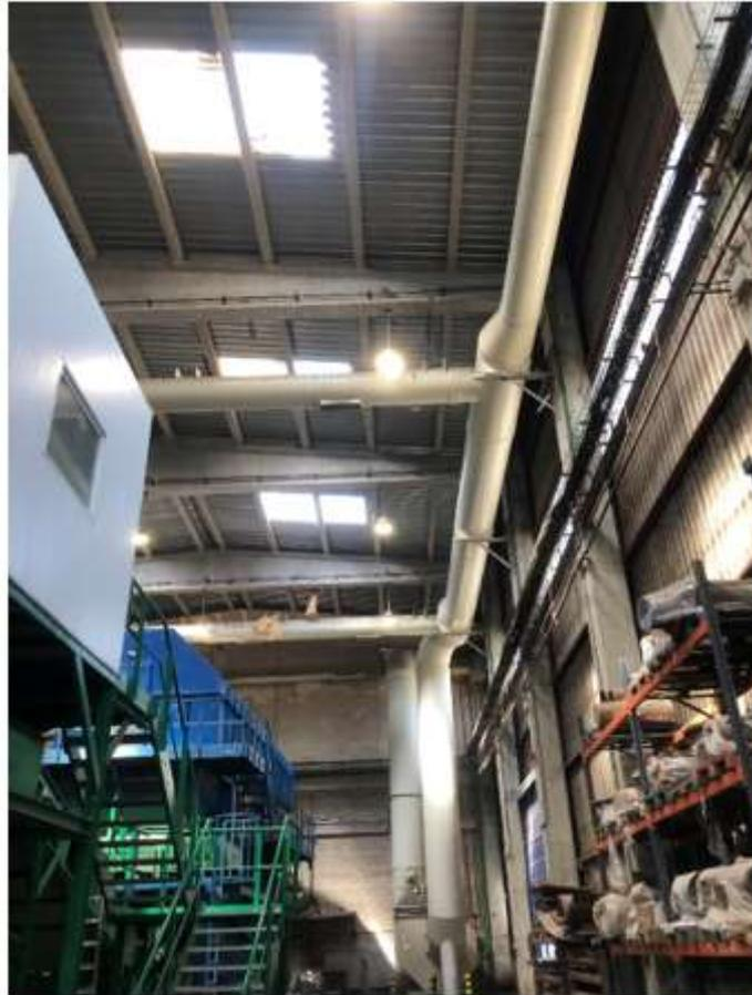
*Figura 57. Conductos de captación de aire en la zona de pretratamiento [6] [58]*
