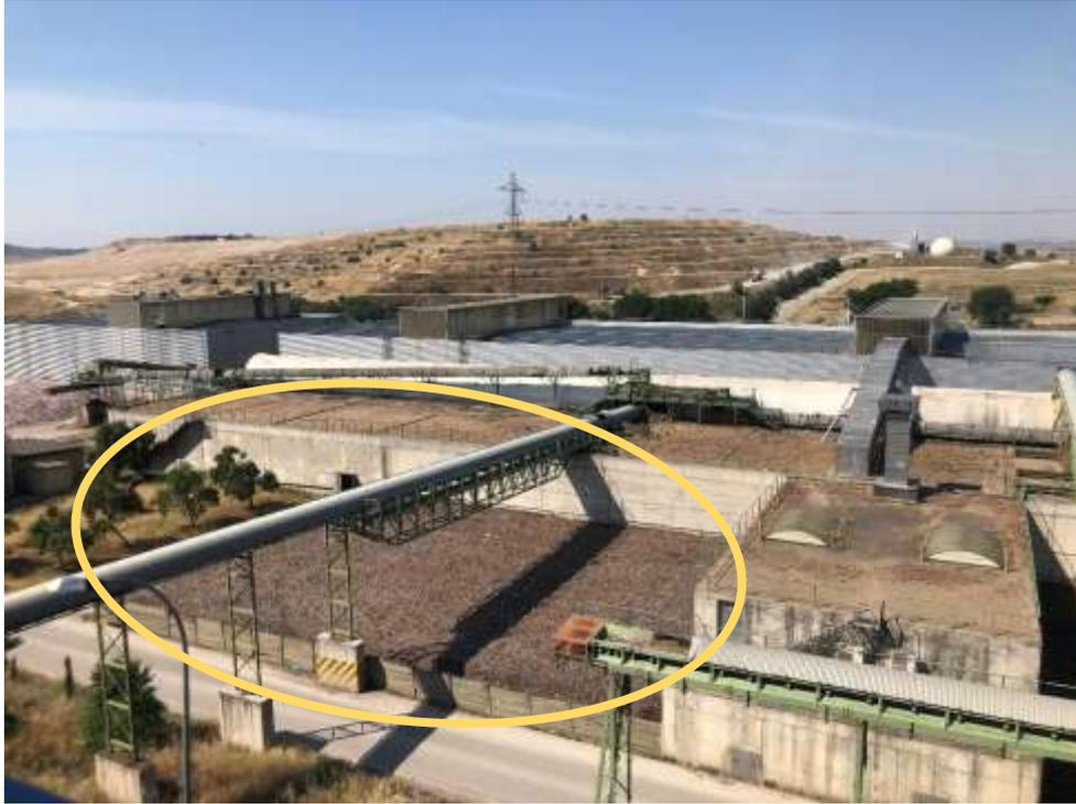
*Figura 20. Biofiltro abierto de relleno orgánico [6] [58]*
