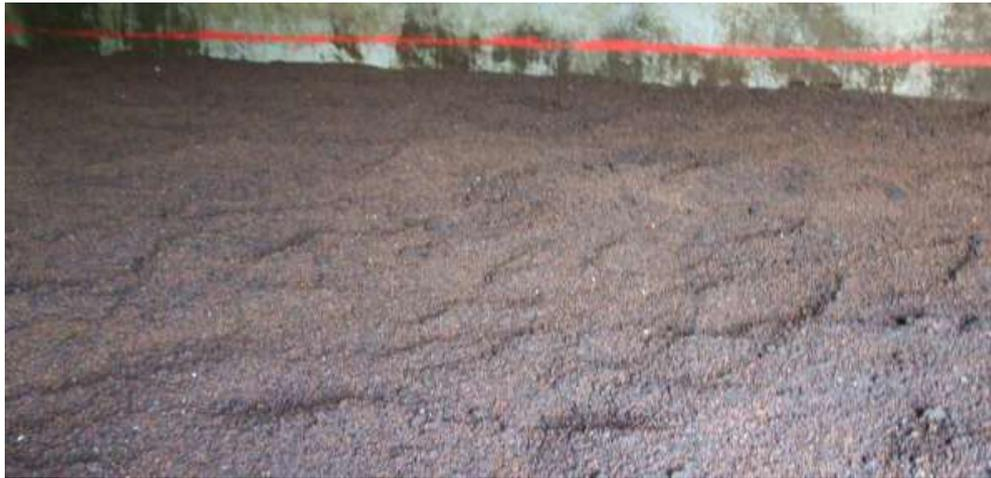
Figura 21. Biofiltro de medio inorgánico utilizado en la Planta Ecoparc del Besos, S.A. [21]
