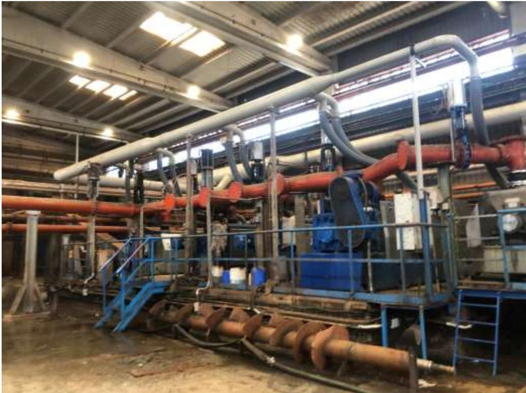
*Figura 52. Tamices para la deshidratación del digesto en la Planta de Biometanización de Las Dehesas [58]*
