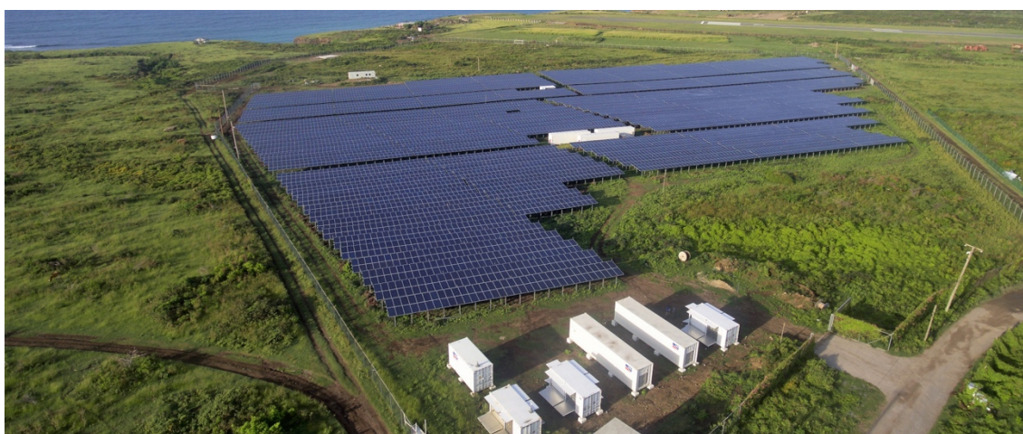
Figura 9: Imagen de la planta solar fotovoltaica y el sistema de almacenamiento por baterías. Fuente: SMA.
