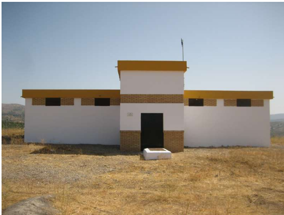
Figura 10: Vista frontal deposito de Santa Ana
