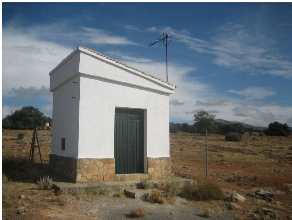
Figura 7: Vista frontal del Sondeo de Los Llanos I
