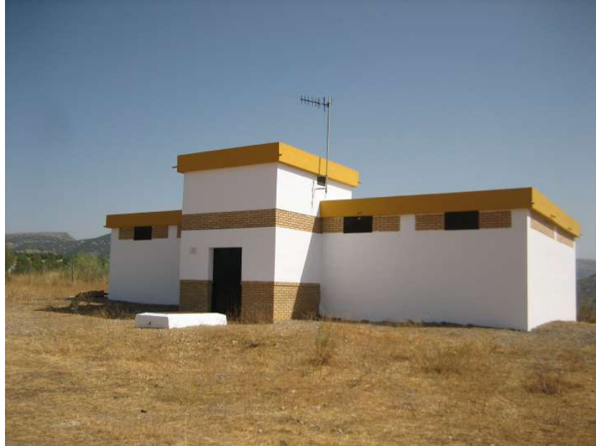
Figura 9: Vista lateral deposito de Santa Ana
