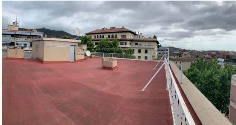
Figura 8: Azotea del emplazamiento escogido
