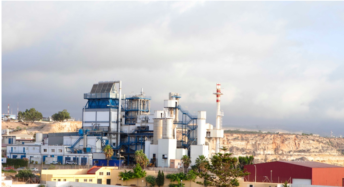
Figura 3.1. Planta de incineración de residuos de Melilla.
