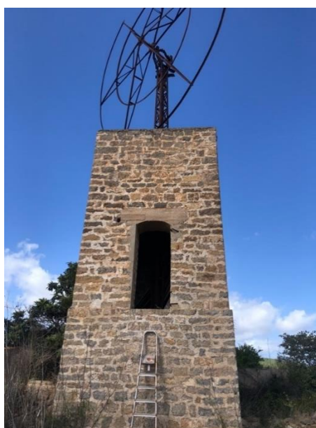
Ilustración 1. Molino sobre el cual se va a proyectar.
